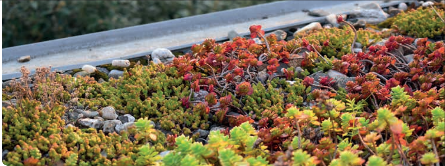
De geïntegreerde spoedpost heeft een groen dak.
